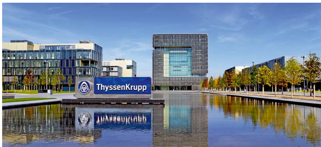
Das MSP-Projekt für ThyssenKrupp umfasst alle 128 Standorte des Unternehmens.
